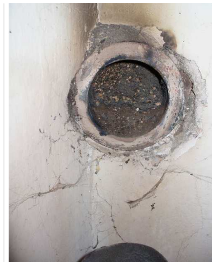
Obr. 2 a 3 – Typický příklad možné otravy CO spaliny spotřebiče na pevné palivo. Spalinová cesta amerických kamen na pevné palivo je dlouhodobě nečištěná a došlo k ucpání sopouchu. Výsledkem je otrava CO. Dlouhodobý únik spalin v sopouchu je patrný zašpiněním omítky a stropu nad kouřovodem.
