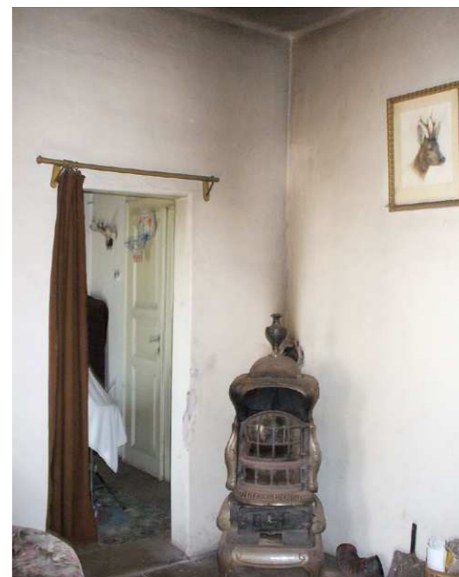
Obr. 2 a 3 – Typický příklad možné otravy CO spaliny spotřebiče na pevné palivo. Spalinová cesta amerických kamen na pevné palivo je dlouhodobě nečištěná a došlo k ucpání sopouchu. Výsledkem je otrava CO. Dlouhodobý únik spalin v sopouchu je patrný zašpiněním omítky a stropu nad kouřovodem.
