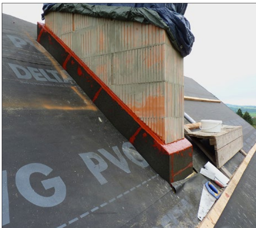
Parotěsný prostup na tříprůduchovém komíně CIKO
